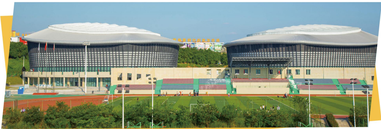
室内恒温游泳馆、体育馆
