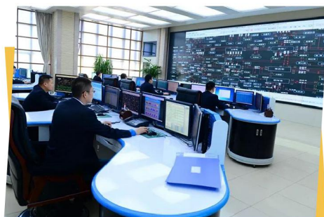
某电网调度控制中心
